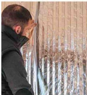
Très simple à mettre en œuvre, cet isolant offre des performances qui permettent d'atteindre les objectifs de la réglementation thermique en vigueur. Elles peuvent être encore plus élevées en aménageant une lame d'air mais il faut consentir à une plus grande perte de surface habitable.
